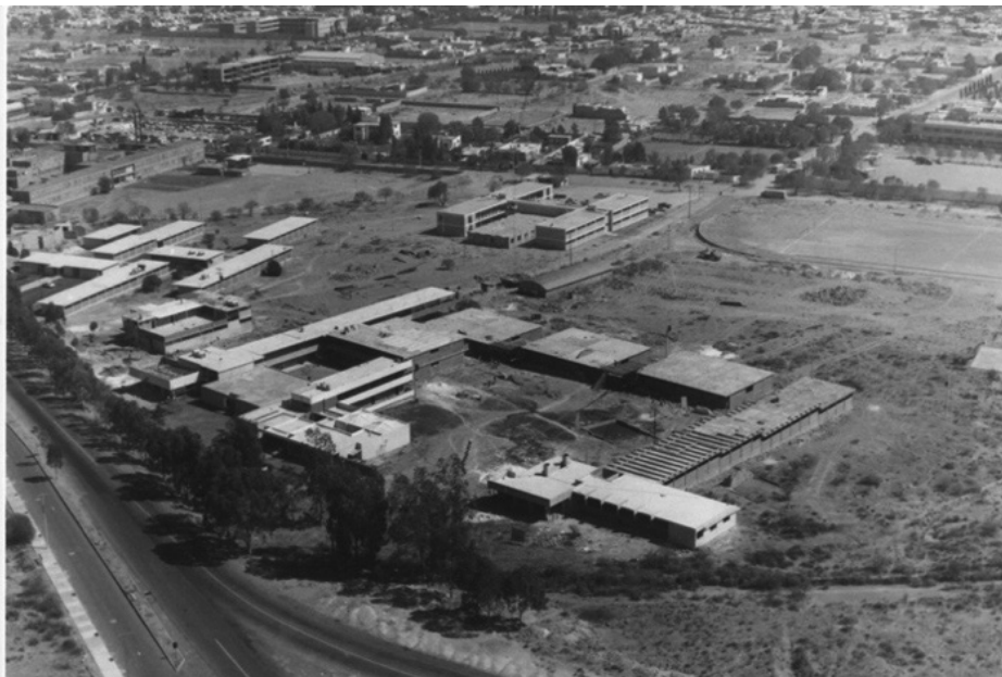
Imagen 2. Las obras del campus universitario. En un primer plano se encuentra la escuela de Ciencias Químicas.
