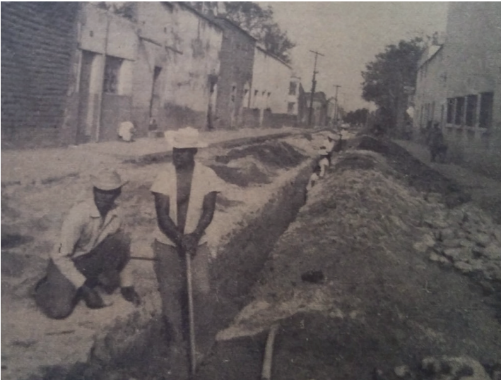
Fotografía 2. Introducción del drenaje en las calles Ramón Corona y Cuauhtémoc, 1972
