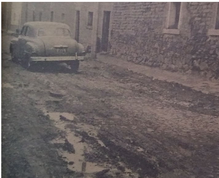
Fotografía 3. Drenaje roto en la calle Emiliano Zapata, 1973
