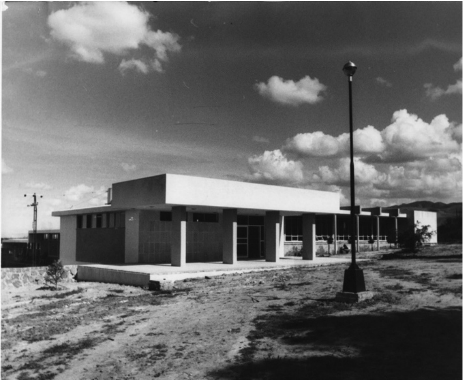
Imagen 1. La construcción de la Escuela de Ciencias Químicas
